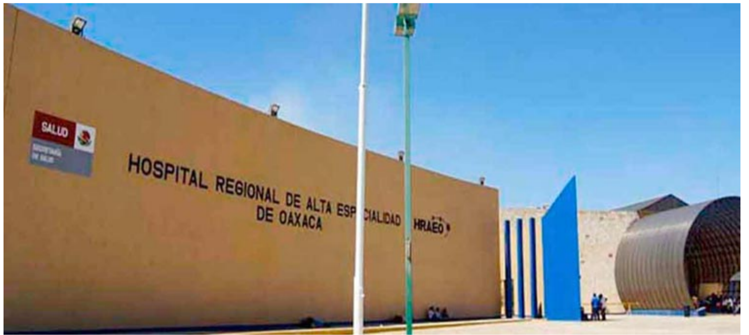
Hospital de Alta Especialidad de Oaxaca
